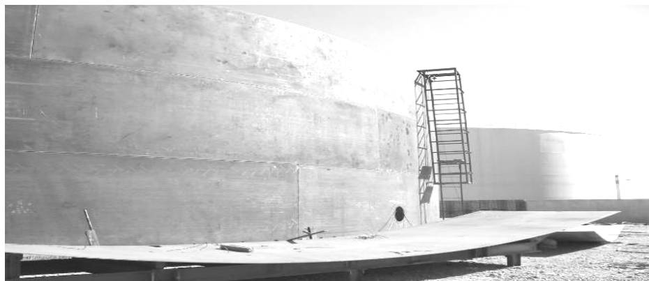
(عکس ۸-۴) دریچه ها روی ورق های ردیف اول بدنه
