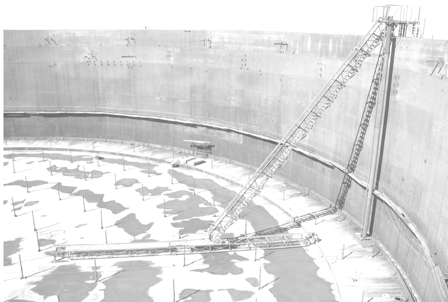
(عکس ۱-۴) مکانیزم پله متحرک در سقف شناور
