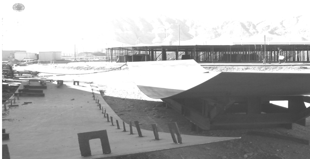
عکس ۳-۶. پایه های ساخته شده سقف شناور دیده میش
