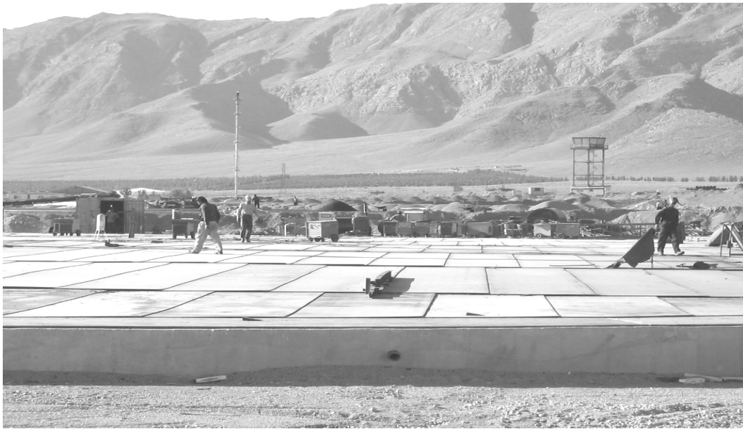
(عکس ۴-۴) چیدن ورق های کف مخزن
